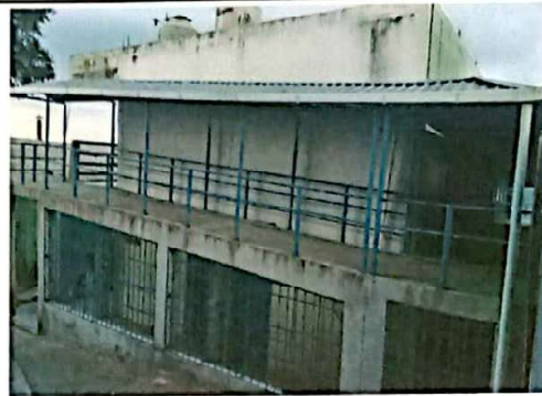
Foto 2: Sustrucción y bajada de agua
