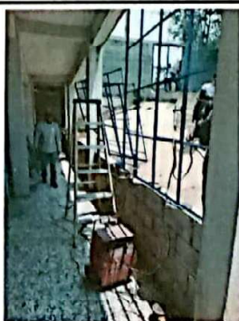
Foto 5: Sustrucción de ventanas por metal con vidrio
