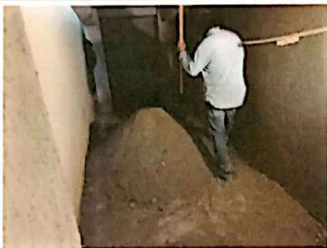
Foto 3: Repello de muro y piso
