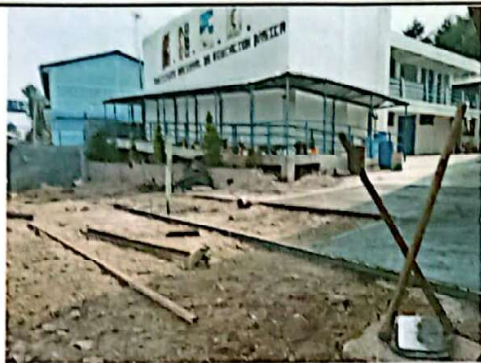
Foto1: Sustrucción de piso de concreto
