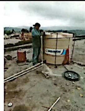
Foto 6: Sustrucción de deposito de agua
