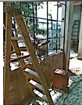
Foto 4: Sustrucción de ventanas por metal con vidrio
